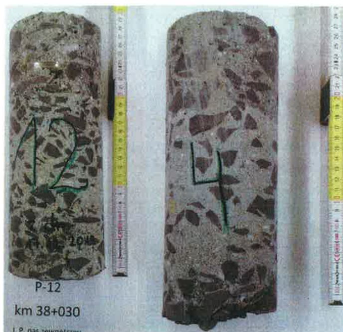
Fot. 5. Przykłady pobranych walcowych próbek nawierzchni droga krajowa nr 18 [7]
