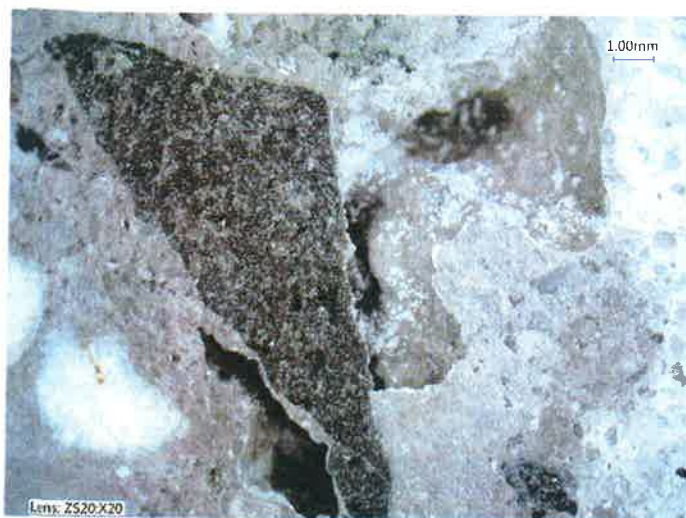
Fot. 30. Próbką 1118/19 – górna warstwa betonu, widoczne nieregularne pustki przy ziarnie bazaltu [7]
