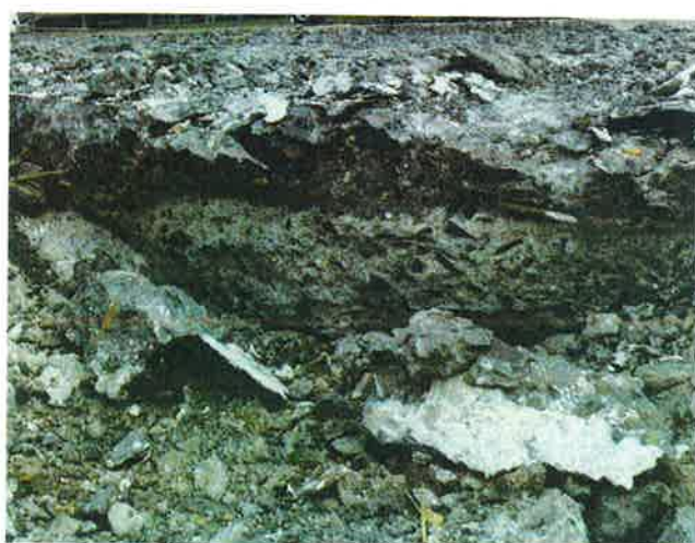
↓ Fot. 3 i 4. Konstrukcja starej nawierzchni betonowej [2]
