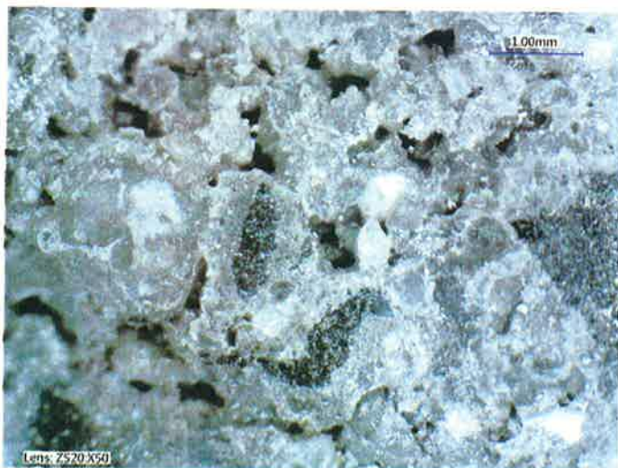
Fot. 31. Próbką 49/20 – dolna warstwa betonu, widoczna porowata struktura betonu [7]
