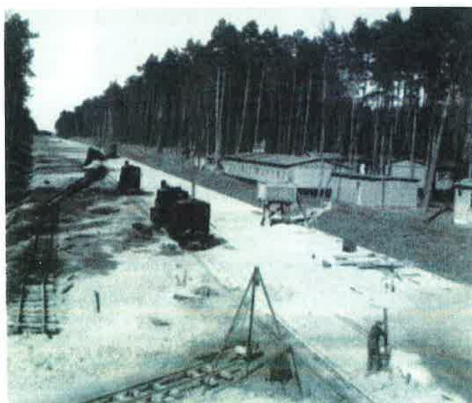
Rys. 2. Grafika – Autostrada RAB 9 w latach budowy [2]
